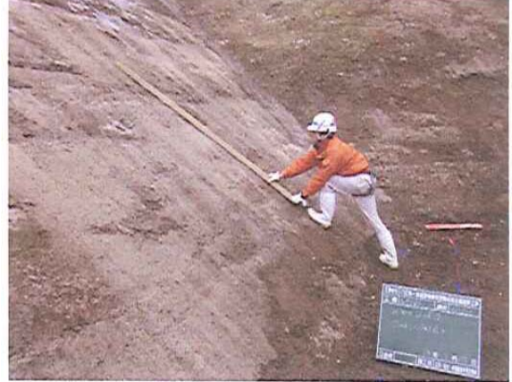
シート敷設前下地検査
