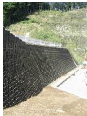
写真3-2 テラセル擁壁
