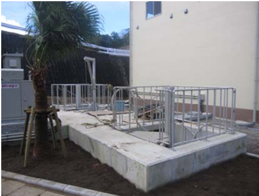
写真 3-12 地下水集水ピット
