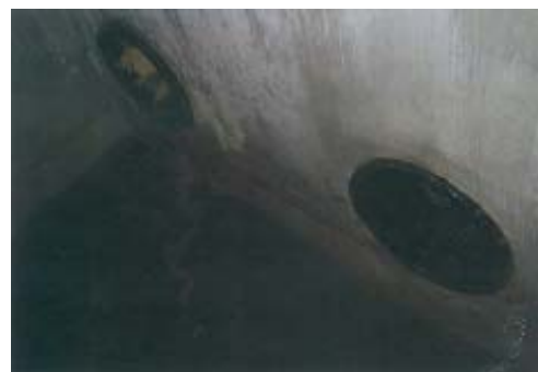
写真3-15 地下水集水ピット内採水部 (A・Bルート管)
