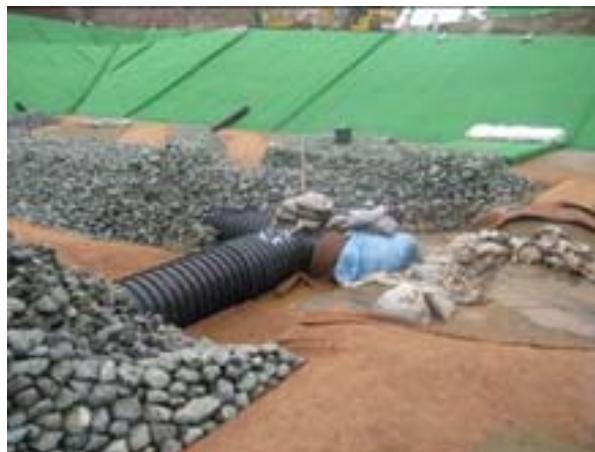
写真3-6 浸出水集排水管施工状況
