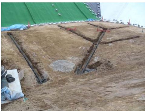
写真3-14 モニタリング管敷設状況
