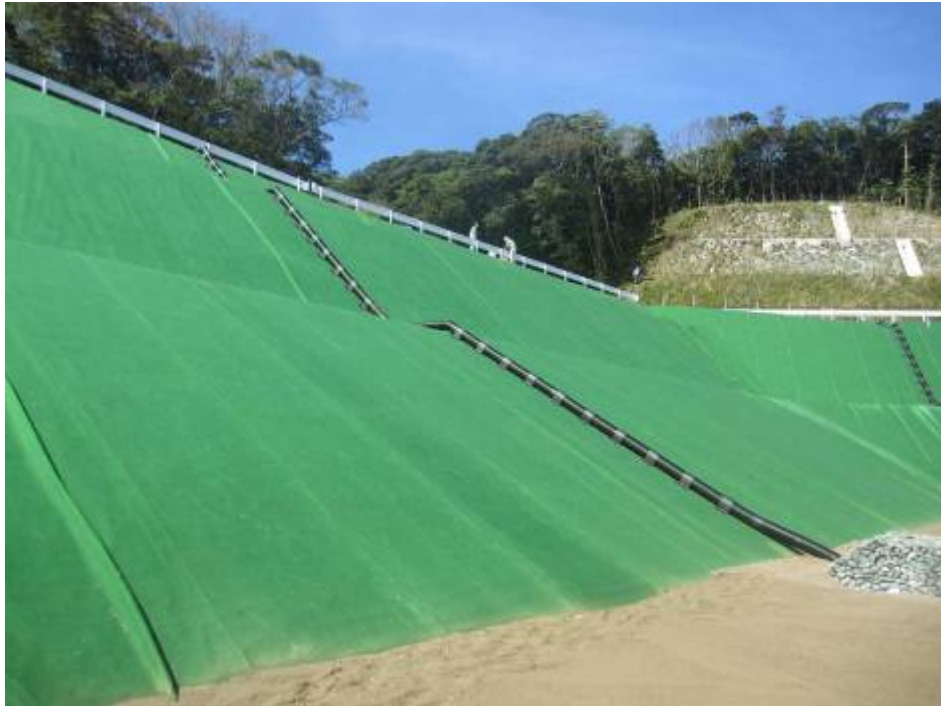
写真 3-9 法面ガス抜き管
