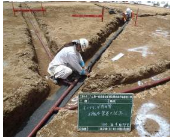
写真3-13 モニタリング管施工状況
