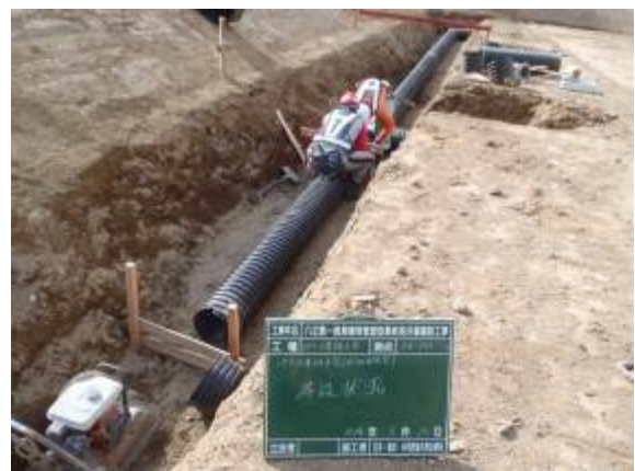
写真3-11 地下水集排水管施工状況
