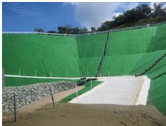
写真3-5 場内道路（埋立地取付部）
