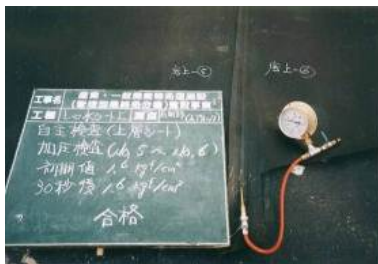
加圧試験状況
