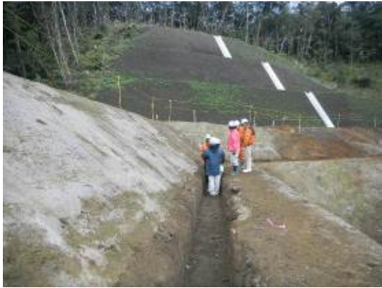
シート下地検査状況
